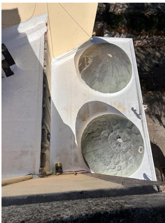
Εικόνα 5 Ολοκλήρωση Υγρομόνωσης Δωματίων Δ4-Δ6
