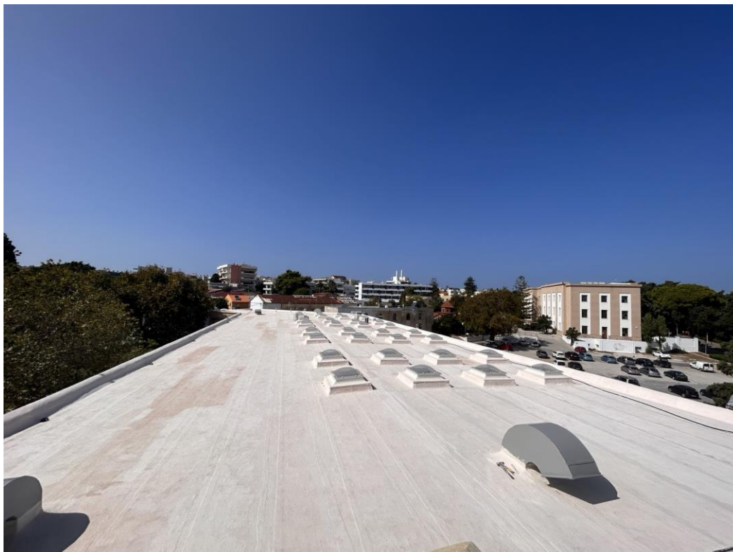
Εικόνα 3 Ολοκλήρωση Υγρομόνωσης Δώματος Δ1
