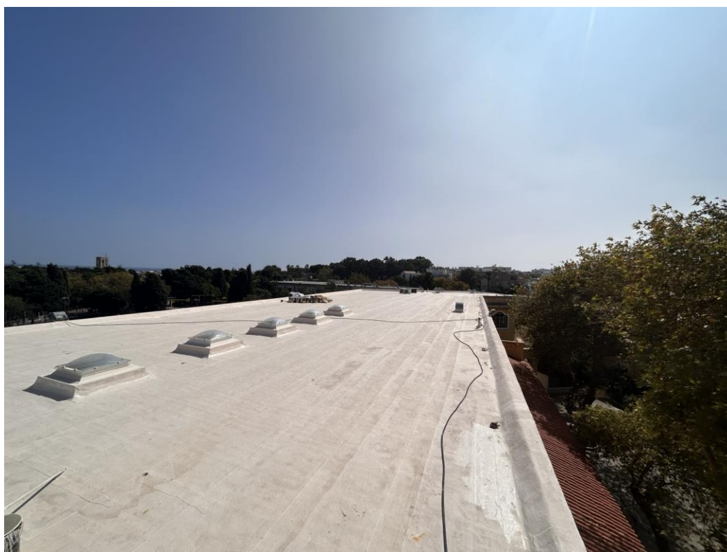
Εικόνα 4 Ολοκλήρωση Υγρομόνωσης Δώματος Δ2
