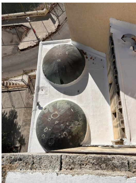
Εικόνα 6 Ολοκλήρωση Υγρομόνωσης Δωματίων Δ5-Δ7
