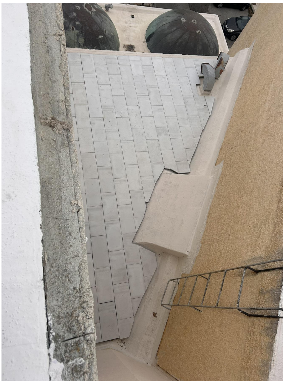
Εικόνα 5 Ολοκλήρωση Τοποθέτησης θερμομονωτικών πλακιδίων στο Δώμα Δ5
