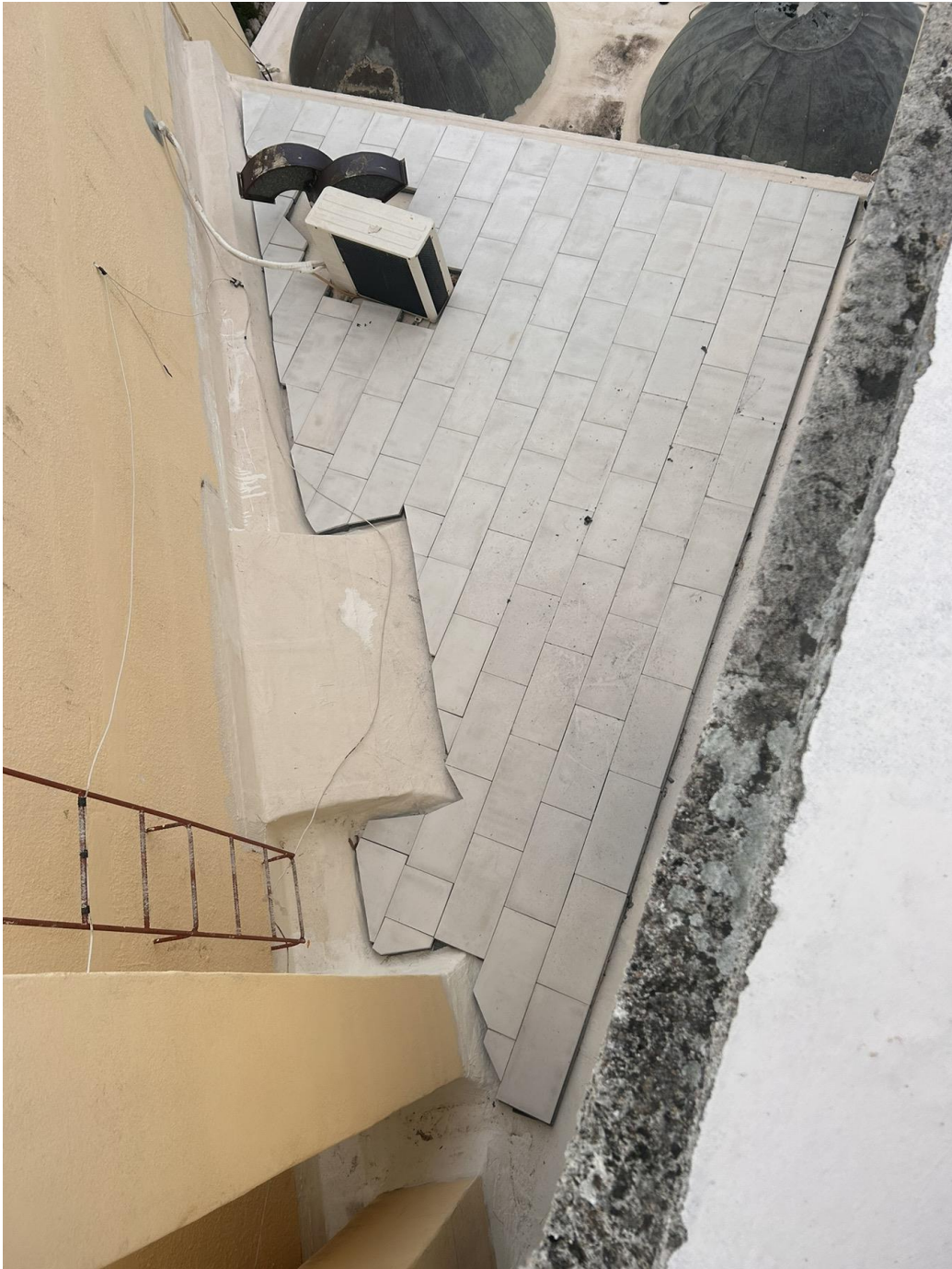
Εικόνα 4 Ολοκλήρωση Τοποθέτησης θερμομονωτικών πλακιδίων στο Δώμα Δ4
