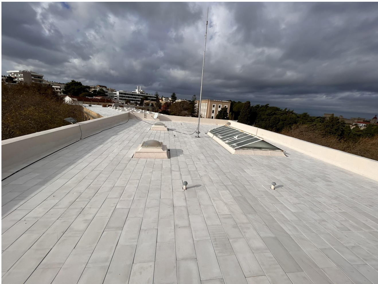
Εικόνα 3 Ολοκλήρωση Τοποθέτησης θερμομονωτικών πλακιδίων στο Δώμα Δ3
