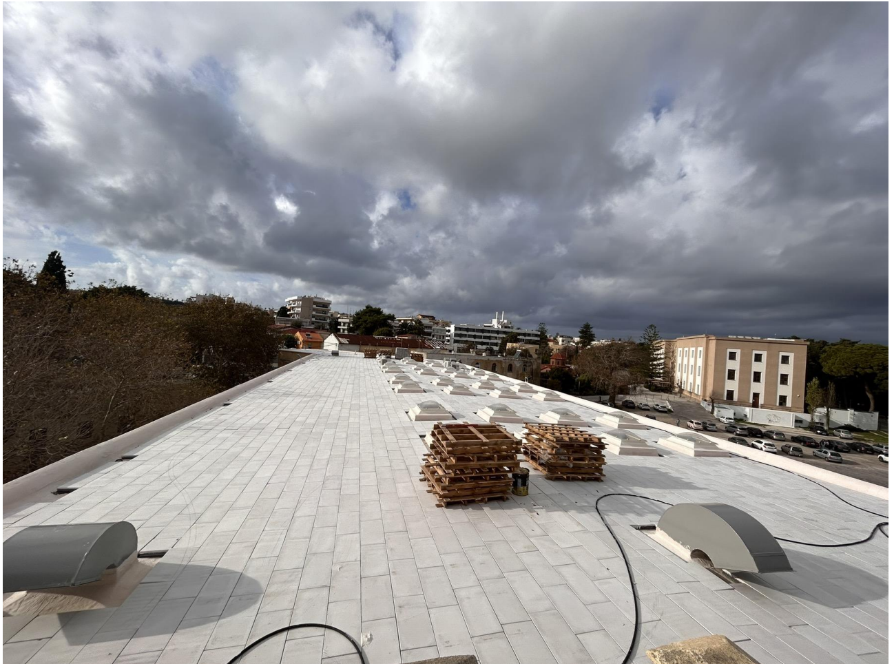
Εικόνα 1 Ολοκλήρωση Τοποθέτησης θερμομονωτικών πλακιδίων στο Δώμα Δ1
