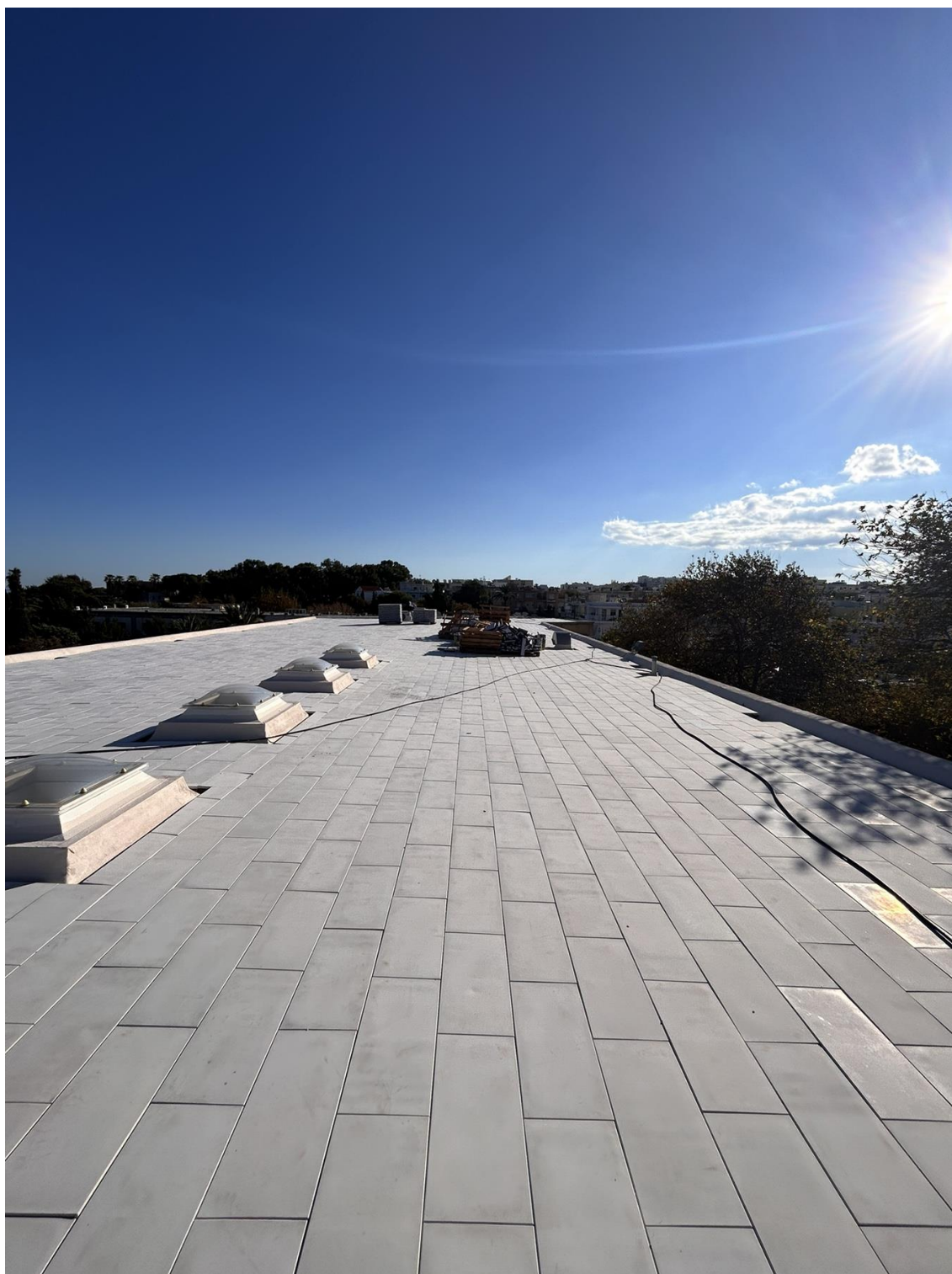
Εικόνα 2 Ολοκλήρωση Τοποθέτησης θερμομονωτικών πλακιδίων στο Δώμα Δ2
