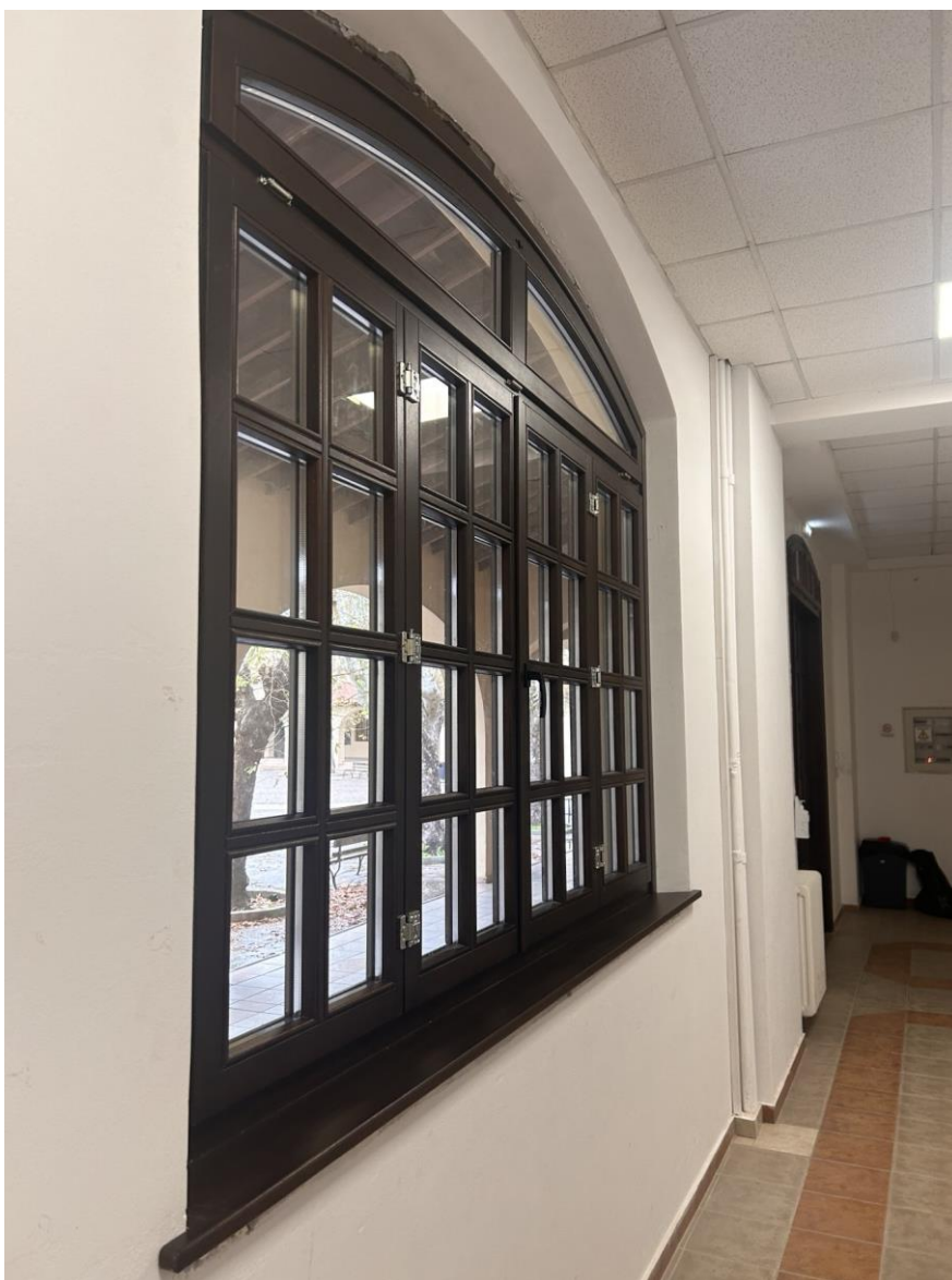
Εικόνα 5 Εγκατάσταση Δοκιμαστικό Κούφωμα τύπου Π1
