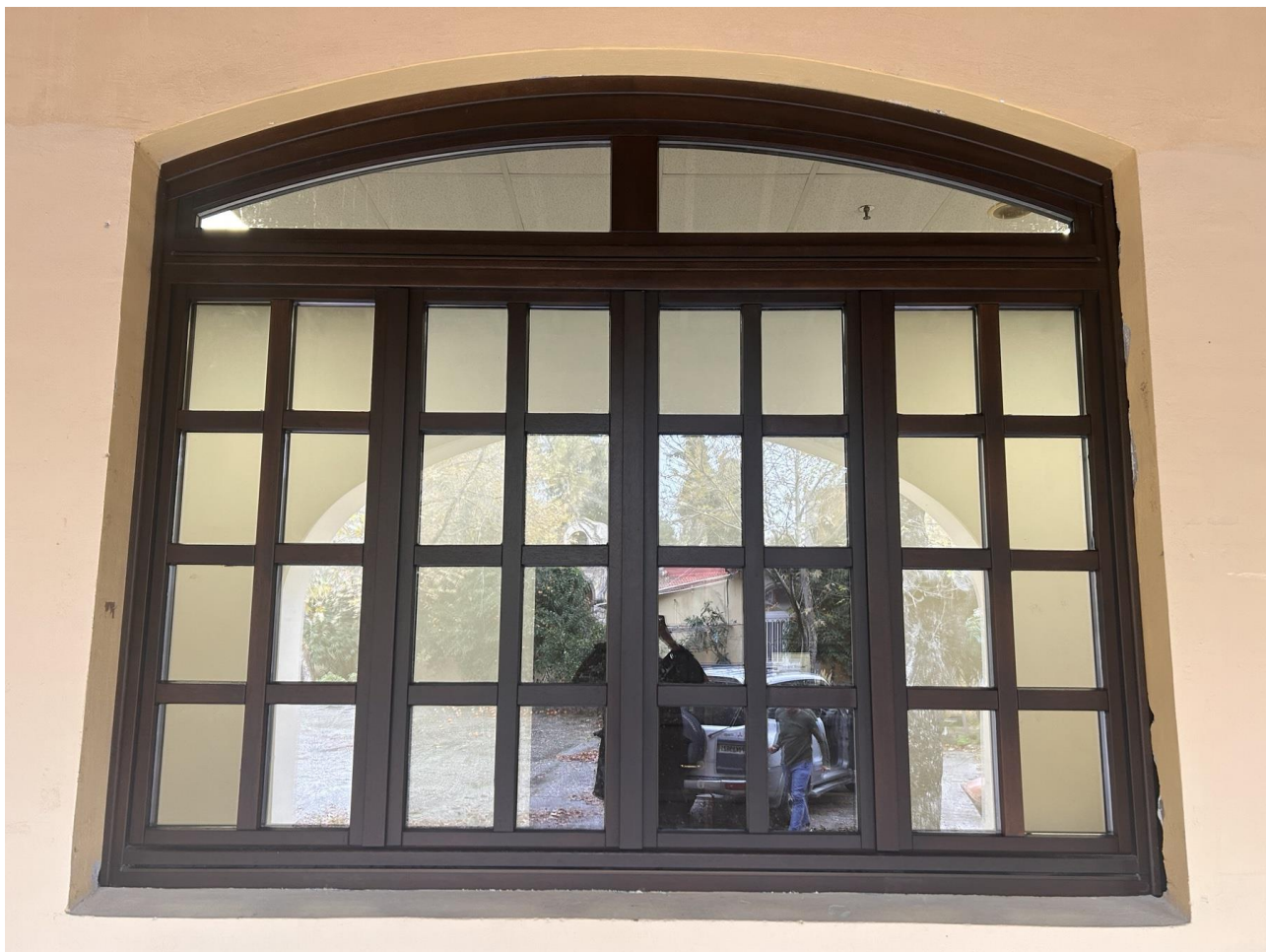
Εικόνα 4 Εγκατάσταση Δοκιμαστικό Κούφωμα τύπου Π1
